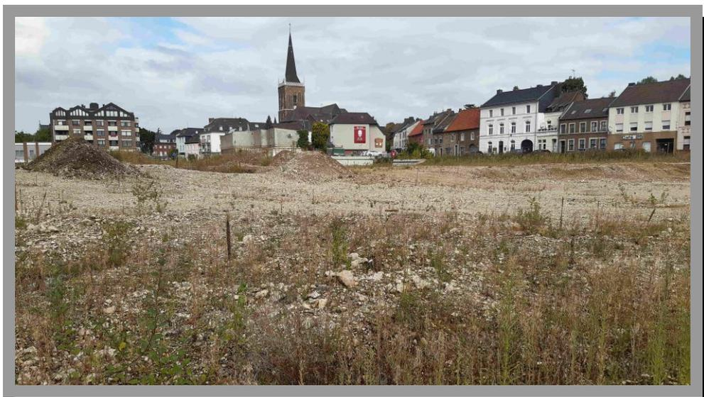
Foto 2: Der lose Untergrund besteht größtenteils aus Kies und Bauschutt.
