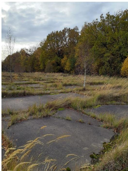
**Abb. 6** Birkenaufwuchs im Bereich der Betonplatten.
