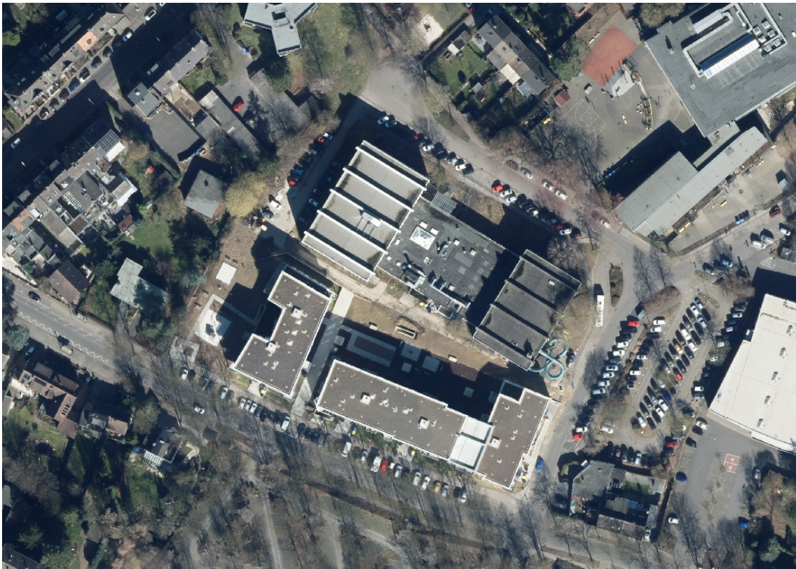
Abb.2: Luftbild [Quelle: geoportal.staedteregion-aachen.de]
