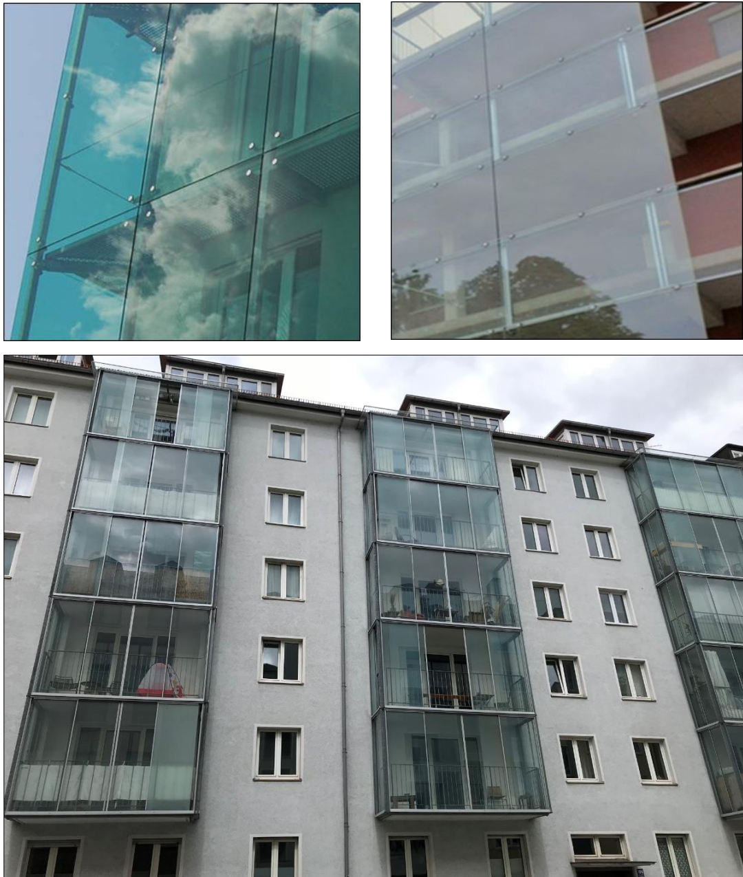
Abbildung 11. Beispiele für vorgesetzte Glasfassaden (die beiden oberen Abbildungen) und teilverglaste Vorbauten (die untere Abbildung).
