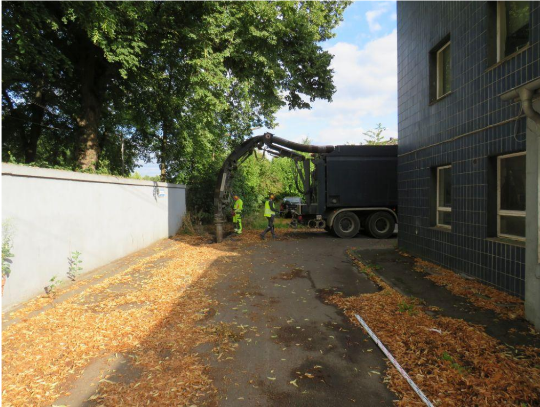
Abbildung 22: Erstellung des Grabens mittels Saugbagger.
