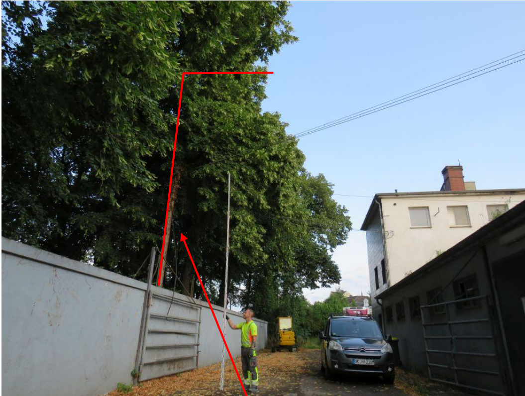
Abbildung 31: Baum 6 Erhöhung des Lichtraumprofils zur Errichtung der Werkhalle.
