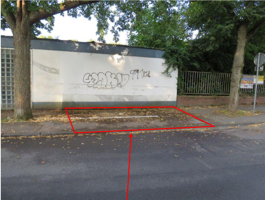
Abbildung 34: Bereich der geplanten Durchfahrt zwischen Baum 1 und 2, der Bereich ist bereits vollflächig asphaltiert.
