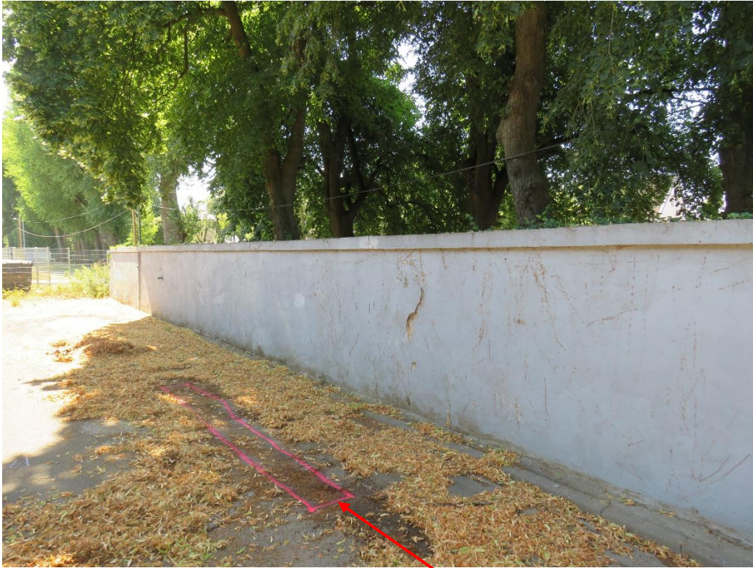
Abbildung 21: Geplanter Wurzelsuchgraben bei Baum 08.
