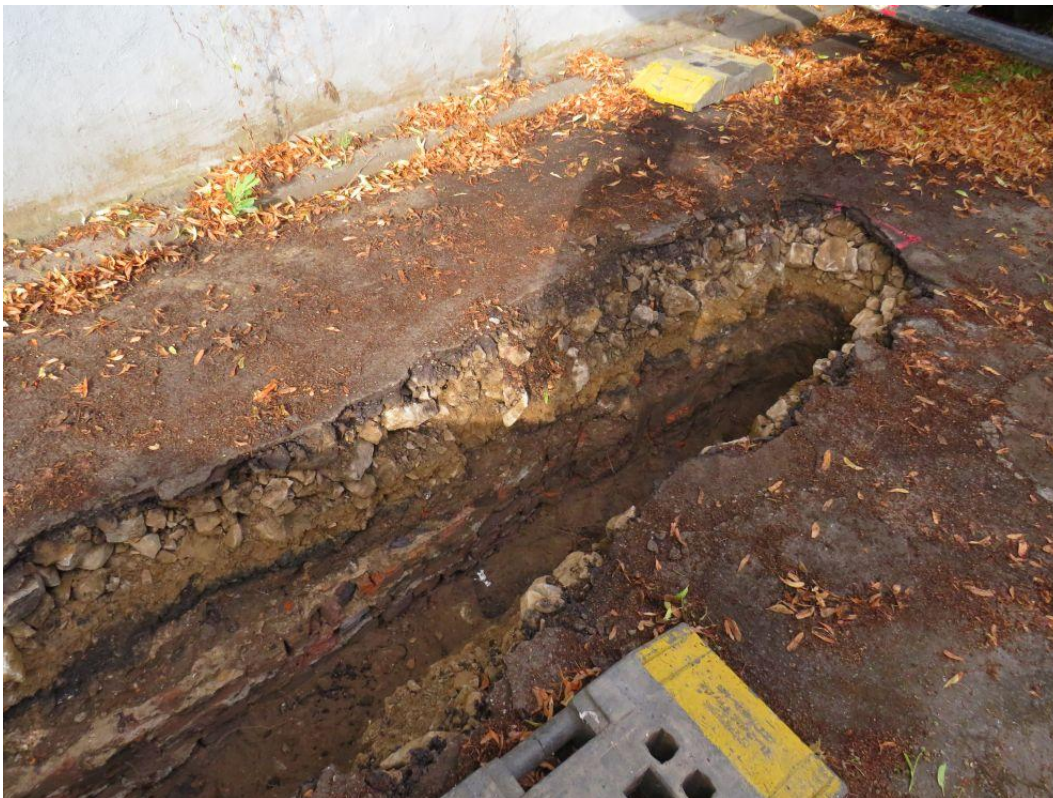
Abbildung 26: Westlicher Teil des Suchgrabens, in den oberen Schichten konnten keine Wurzeln festgestellt werden.
