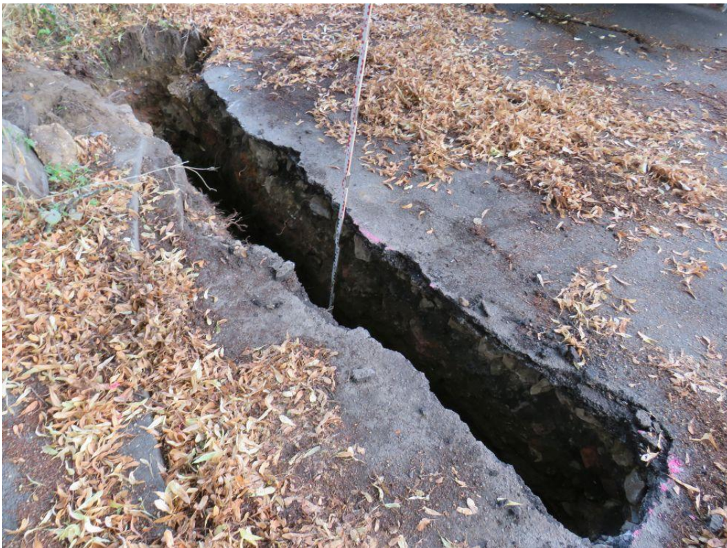
Abbildung 23: Fertig erstellter Suchgraben mit einer Tiefe von etwa 1,00 m.
