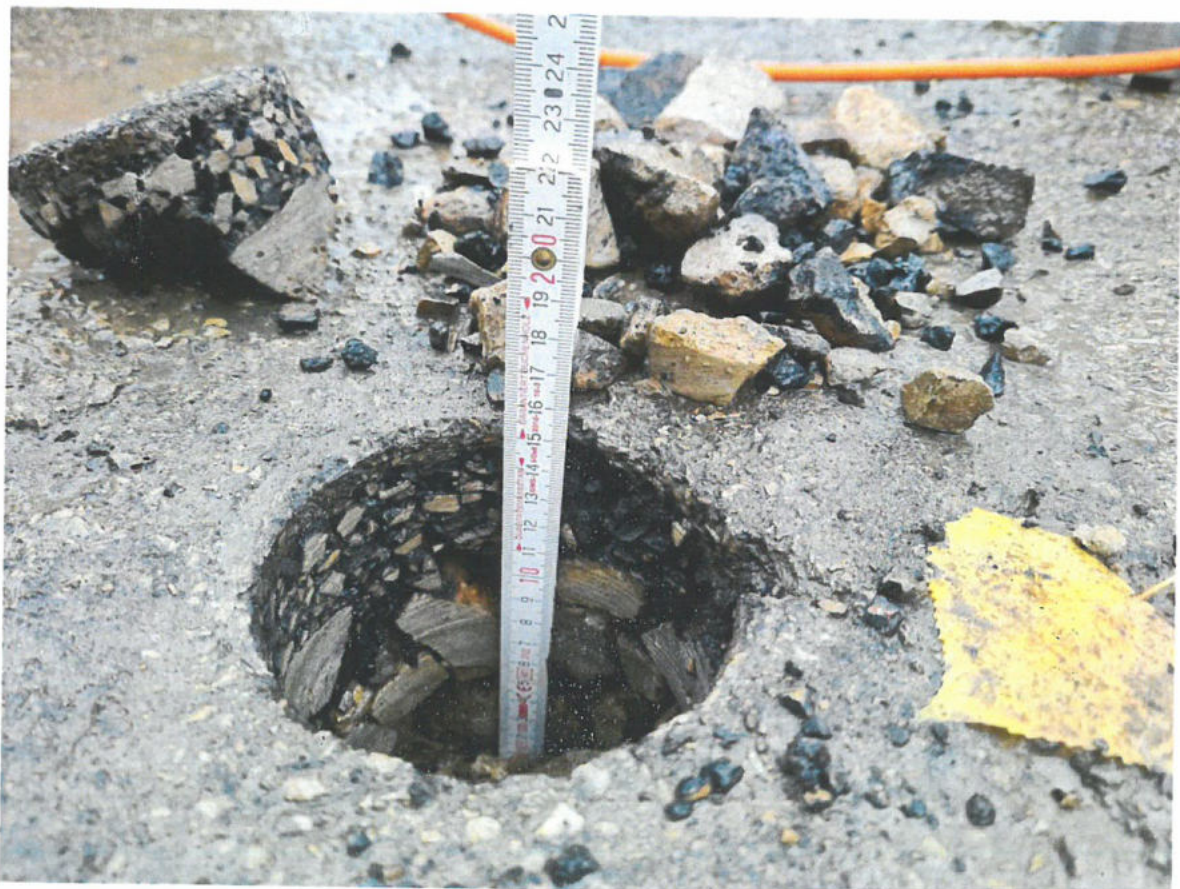
Bild 8: Bohrloch der KB 1 mit Bohrkern und Schottertragschicht am 21.10.2022
