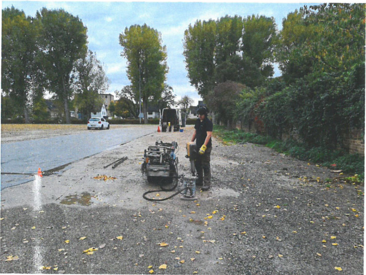
Bild 9: örtliche Situation im Baufeldbereich (Drieschplatz) mit Ausführung der RKS 3 am 21.10.2022
