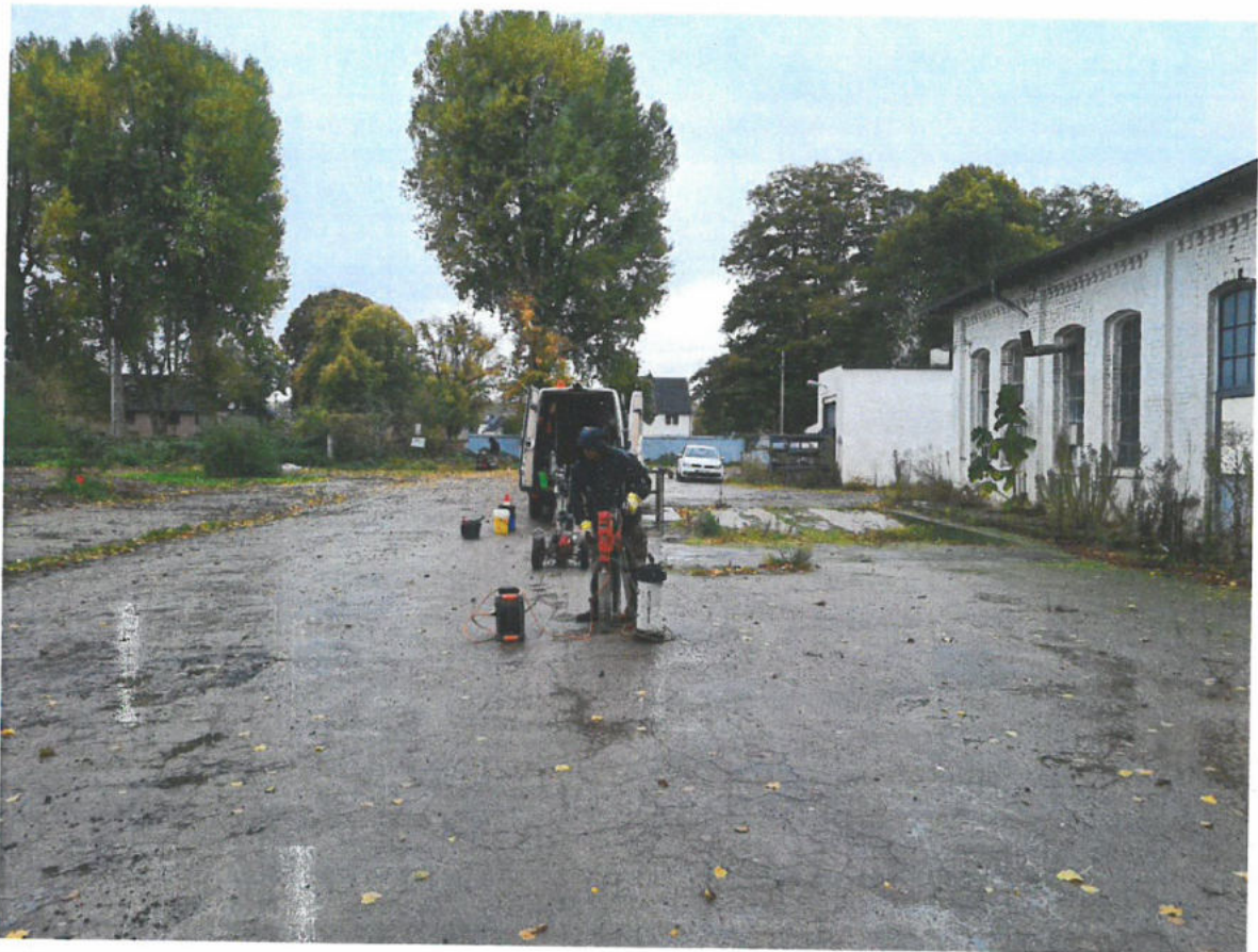
Bild 7: Ausführung Kernbohrung 1 (KB 1) am 21.10.2022
