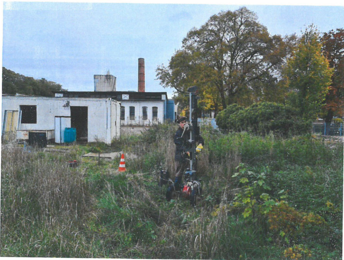
Bild 4: Ausführung DPL 2.2 mit Ansatzpunkt DPL 2.1 (Pylon) am 21.10.2022
