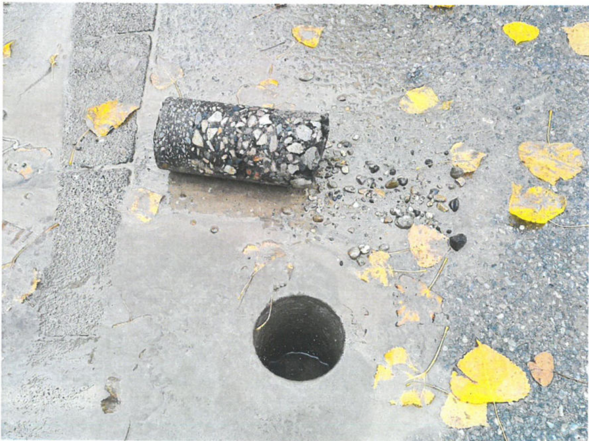
Bild 8: Bohrloch der KB 2 mit Bohrkern am 21.10.2022
