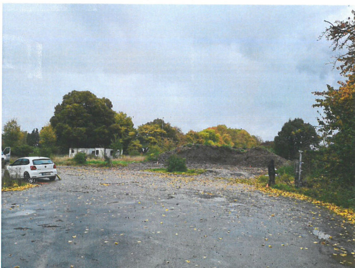
Bild 2: örtliche Situation im Baufeldbereich (Schlachthof) mit Ausführung der DPL 1 am 21.10.2022
