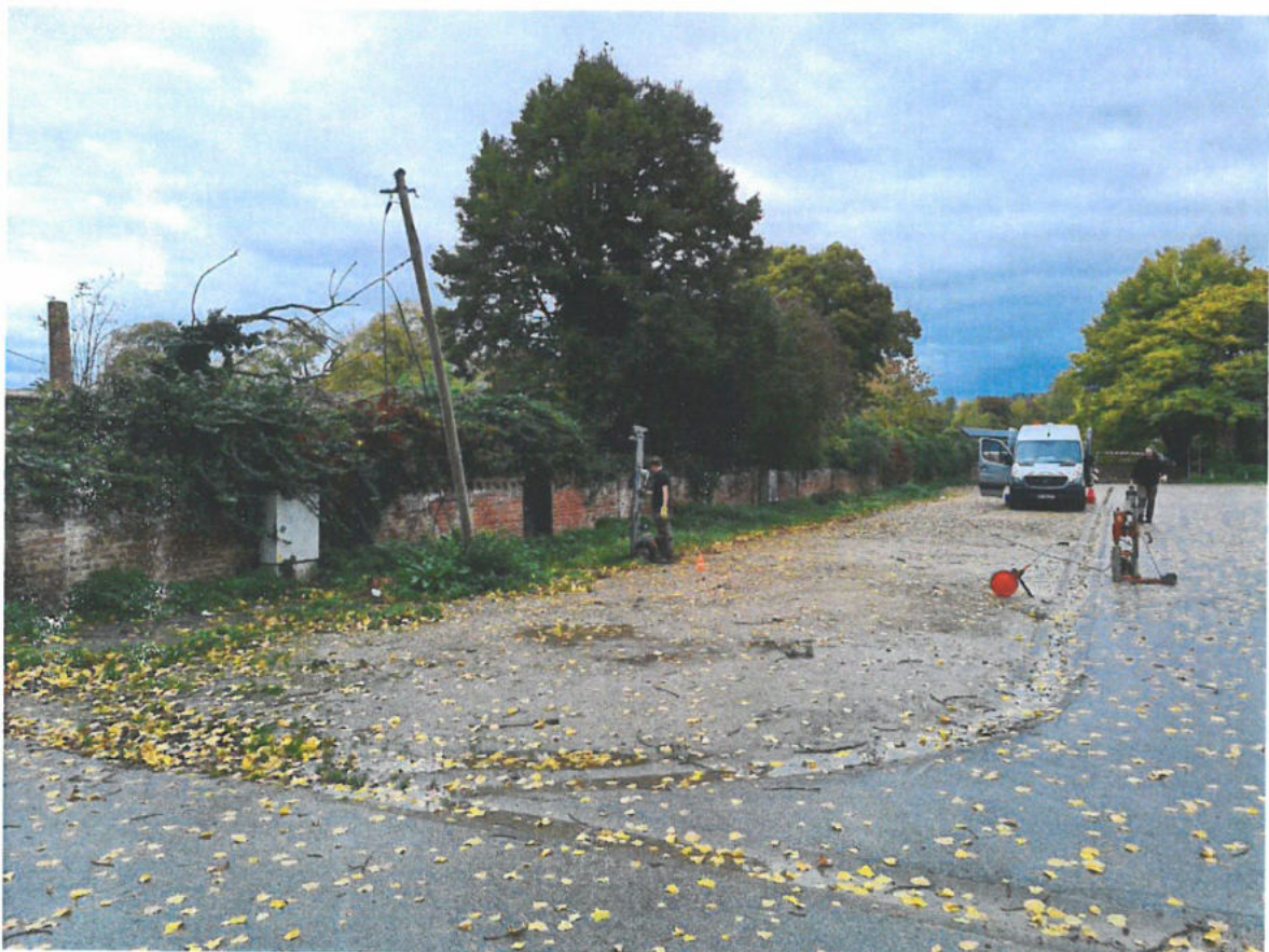
Bild 10: örtliche Situation im Baufeldbereich (Drieschplatz) mit Ausführung der DPL 3 (links) sowie mit Ansatzpunkt KB 2 (rechts) am 21.10.2022
