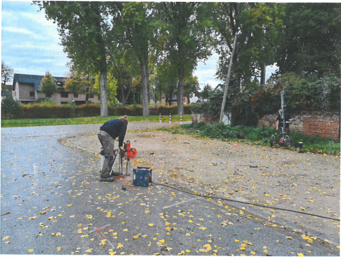
Bild 11: Ausführung Kernbohrung 2 (KB 2) am 21.10.2022
