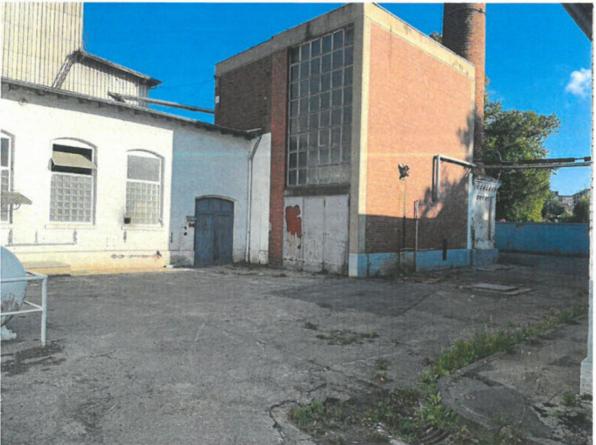
Bilder 5 und 6: örtliche Situation im Bereich des alten Schlachthofs am 18.08.2025
