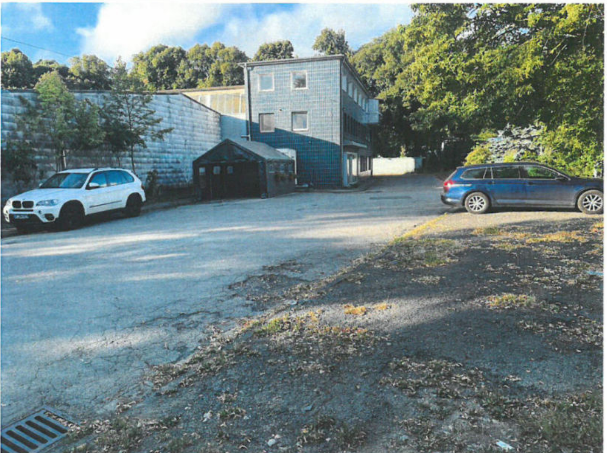
Bilder 1 und 2: örtliche Situation im Bereich des alten Schlachthofs am 18.08.2025
