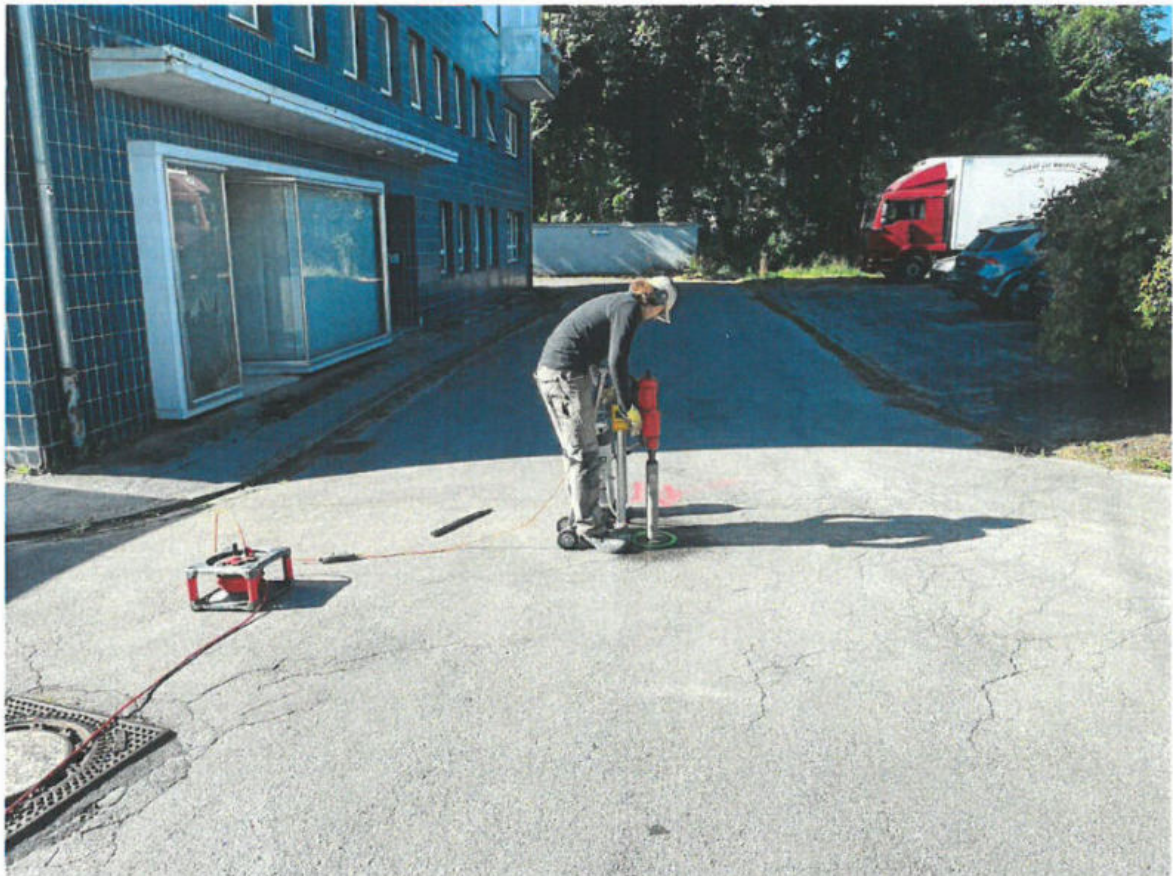
Bild 9: Ausführung der Kernbohrung durch die Schwarzdecke bei RKS 1/25 am 18.08.2025
