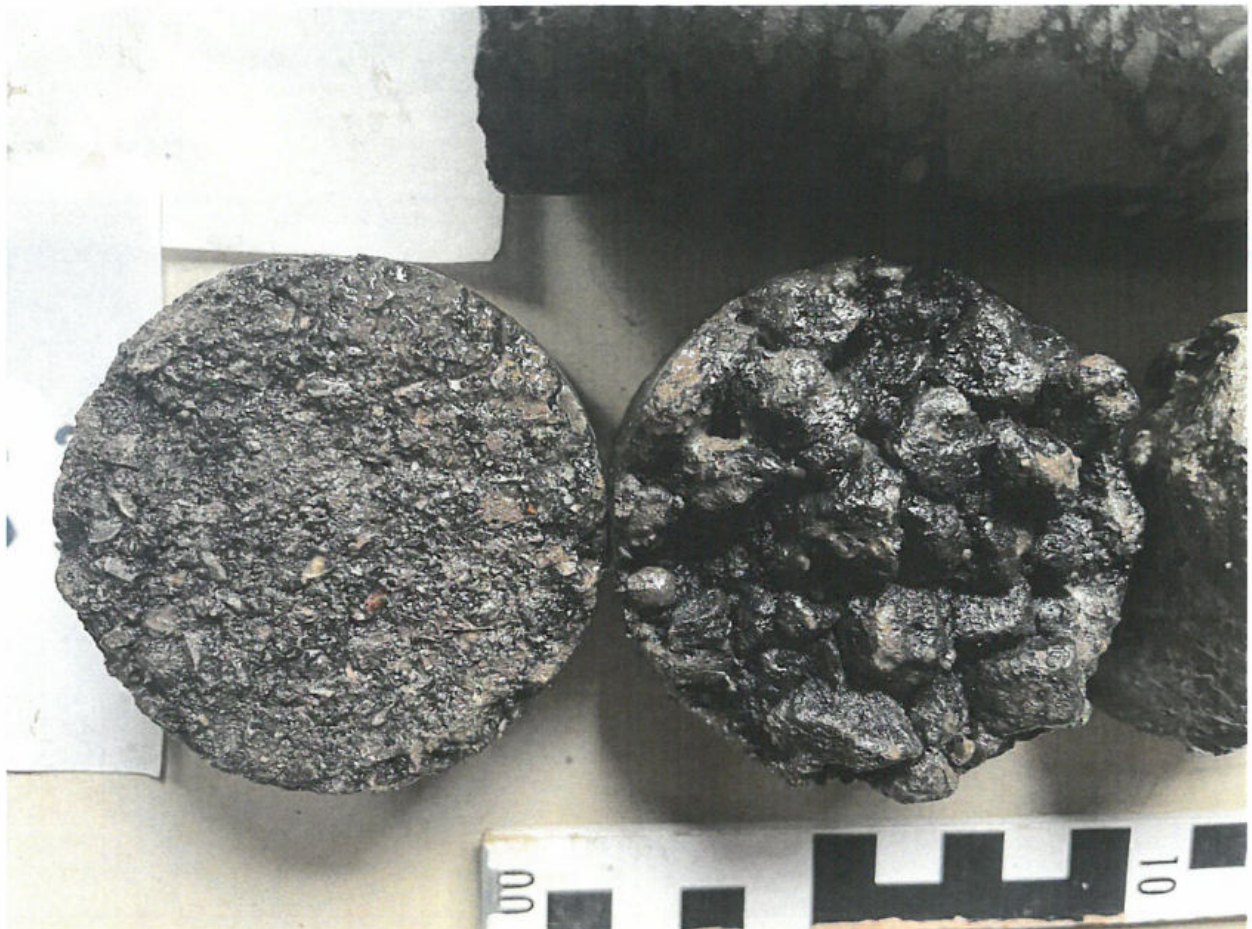
Bild 4: Detail Unterseiten der Schwarzdeckenkernstücke KB/RKS 3 mit Anspritzbelag an der Basis
