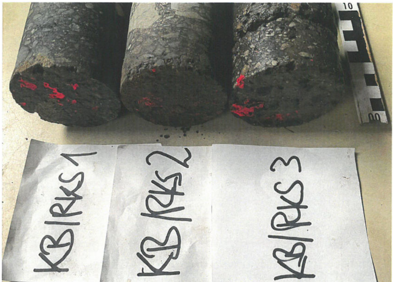
Bild 2: Detail Oberseiten der Bohrkern KB/RKS 1 – KB/RKS 3 vom 08.12.2025
