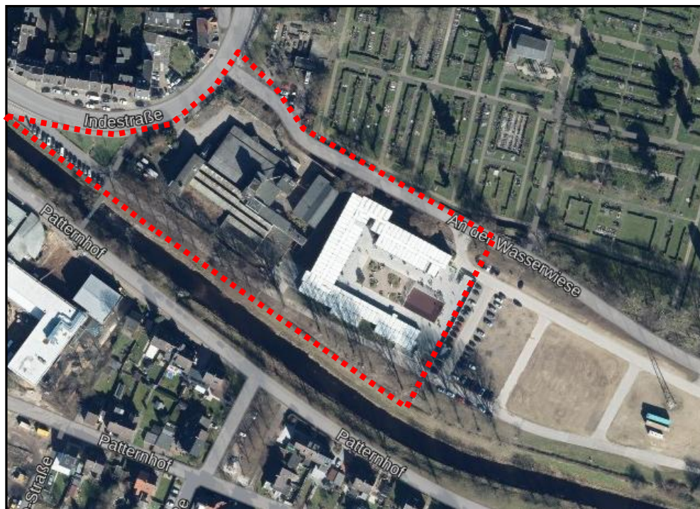
Neben dem verbliebenen Gebäudebestand wurde im Ostteil des Plangebiets temporär eine Schule in Container-Bauweise errichtet. Maßstab ca. 1 : 5.000
