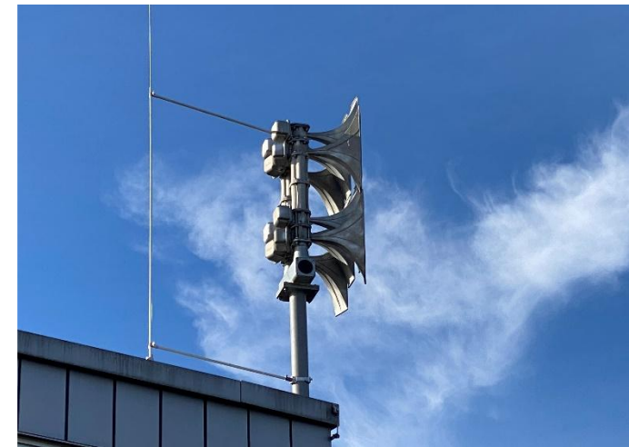
Sirene auf dem Rathausdach der Stadt Eschweiler
